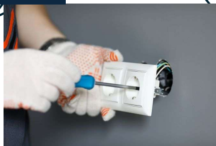
Nya eluttag installeras
