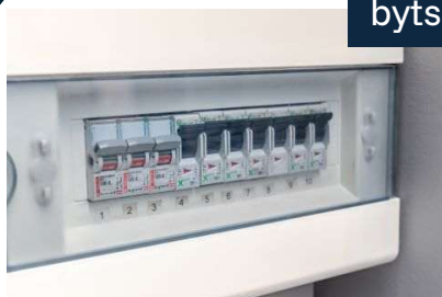
En ny elcentral monteras i lägenheten
