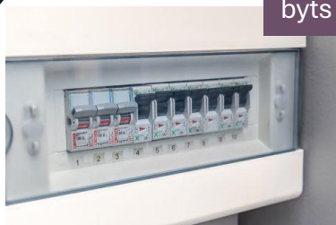
En ny elcentral monteras i lägenheten
