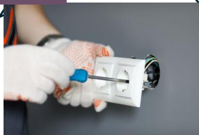
Nya eluttag installeras
